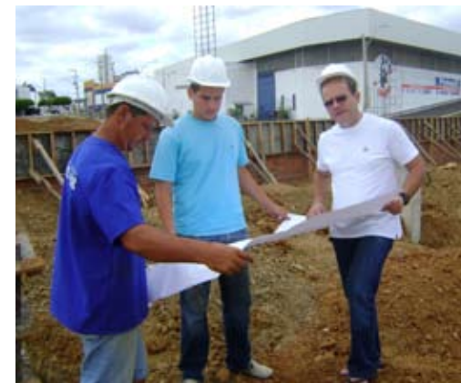
O Secretário da Saúde, Carlos Hilton, visita canteiro de obras da CAF
